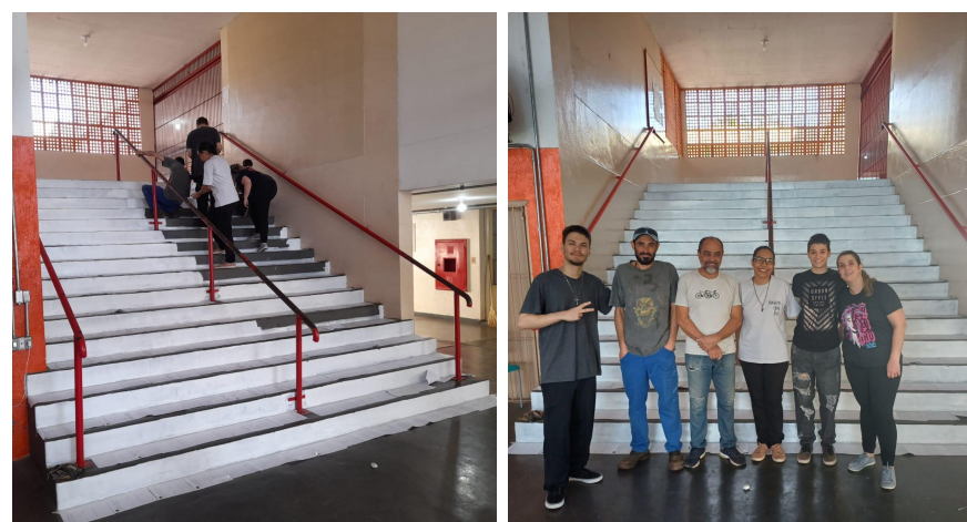
Figura 2: Retirada Parcial da pintura antiga
